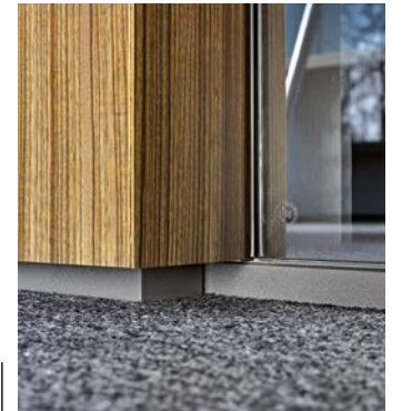
4. Jonction du verre avec la structure du Bridge et profil en retrait
