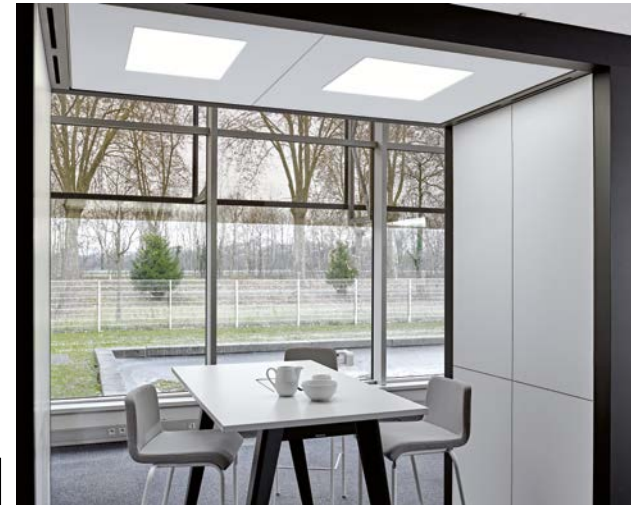
Plafond métallique avec intégration de luminaires
