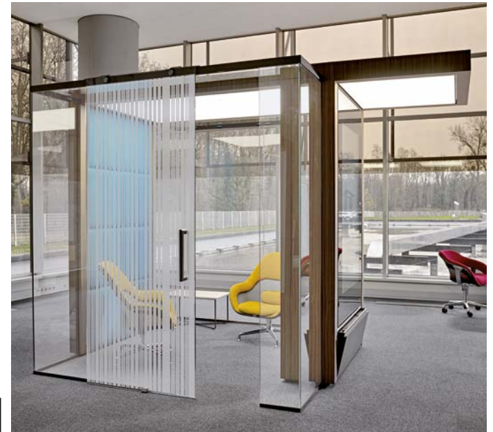
Verre opacifiant, position ON et film adhésif posé sur porte coulissante
