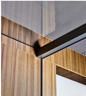
1. Connexion entre le verre de la cloison et un habillage bois du Bridge
