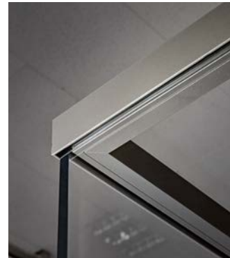
3. Vue en partie haute de la jonction vitrée et de la lisse haute servant de goulotte de câblage
